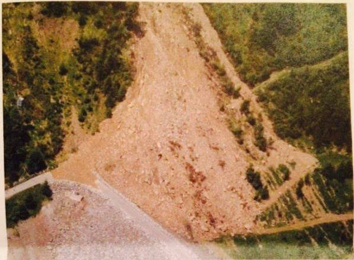
Einschüttung des westlichen Dammbereiches, Stand 10.06.2015
