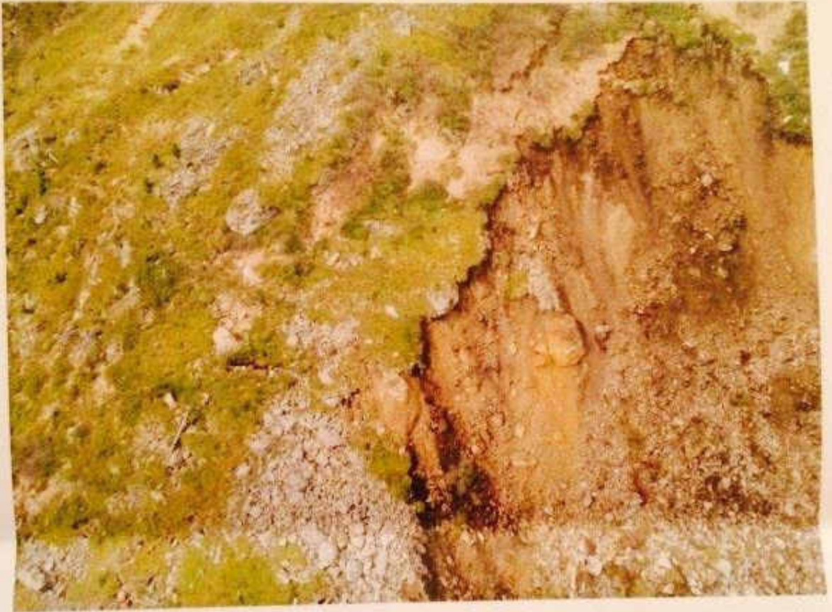
Bereich Nord aus der Luft, einschließlich offener Spalten taleinwärts
